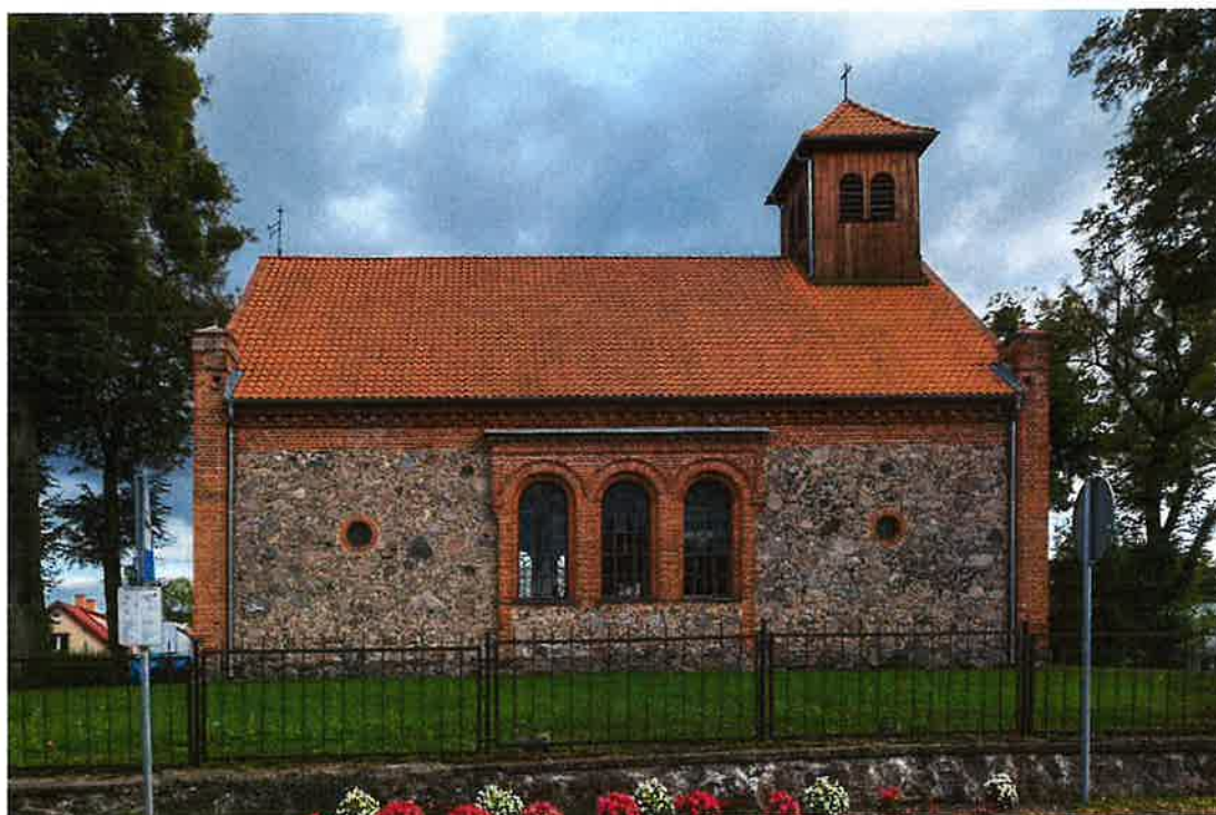
Fot. 4. Kościół w Rybnie. Elewacja północna.
