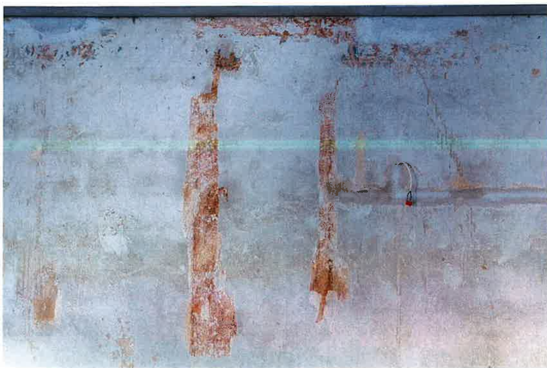
Fot. 47. Zachodnia część ściany południowej. Tylko w tej części zachował się fragment fryzu, który prześwituje przez współczesną, białą warstwę malarską. Elementy dekoracji malarskiej, pochodzącej najprawdopodobniej z lat 30 XX w. wykonane były farbą klejową, nieodporną na działanie wilgoci. Zaciekająca przez nieszczelny dach woda dekoracje rozmyła – na ścianie widoczne są czerwone smugi. ( Odkrywka nr S1 na fot. 9)
