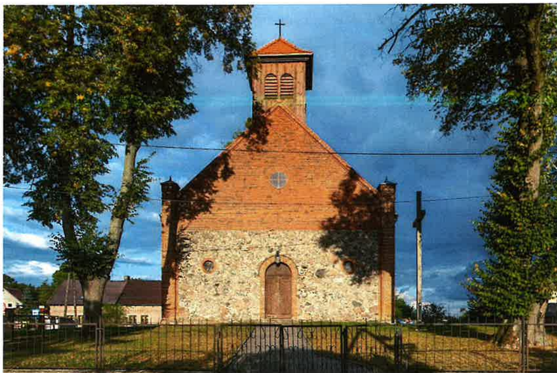
Fot. 1. Kościół w Rybnie – elewacja zachodnia, główne wejście do kościoła.
