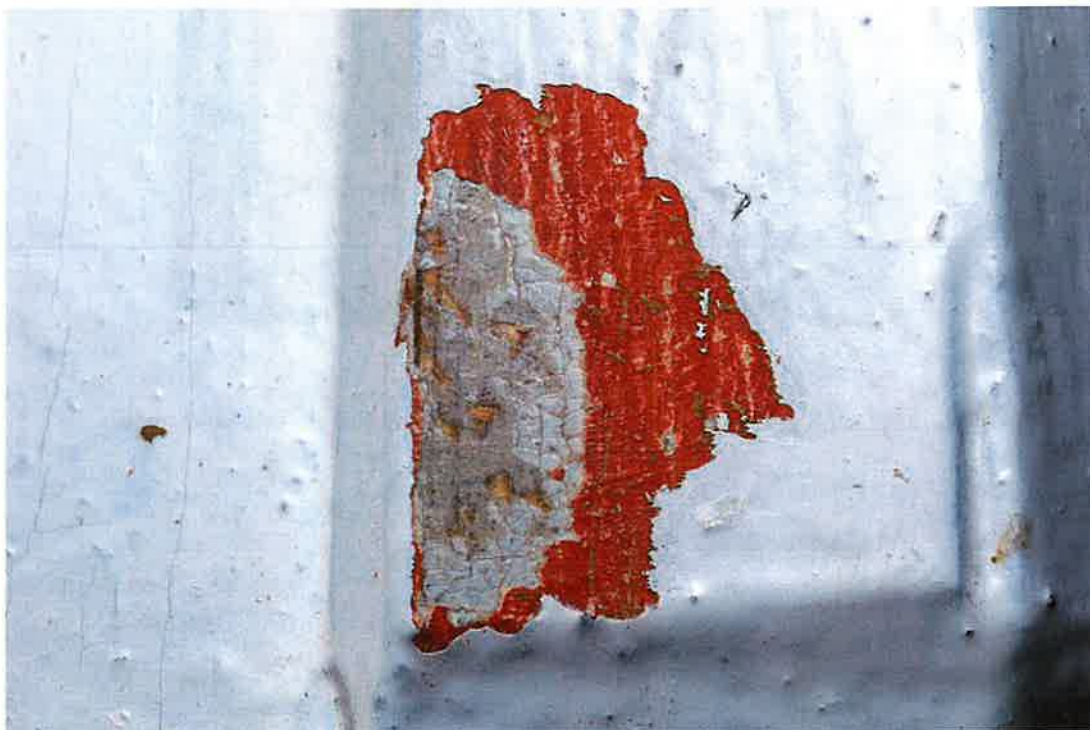
Fot. 23. Ściany ambony mają konstrukcję ramowo-płycinową. Na zdjęciu odkrywka na ramie.
