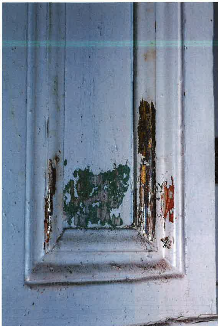
Fot. 19. Odkrywka nr 5 – fragment w obrębie prospektu organowego. Listwy na krawędziach płycin pierwotnie posrebrzono. Metal położono w technice klejowej (na poler) na ciemnoczerwonym pulmencie. Srebro jest częściowo zoksydowane (poczerniałe). W drugiej chronologicznie warstwie listwy pomalowano brąz (być może złotem mineralnym czyli imitacją wykonaną z miki, która nie utlenia się).
