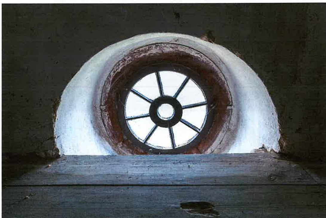
Fot. 36. Trudno dostępne ościeżnice okrągłych okienek także nie zostały przemalowane – brązową farbą pomalowano tylko skrzydła, zapewne dlatego, że można było je zdemontować.
