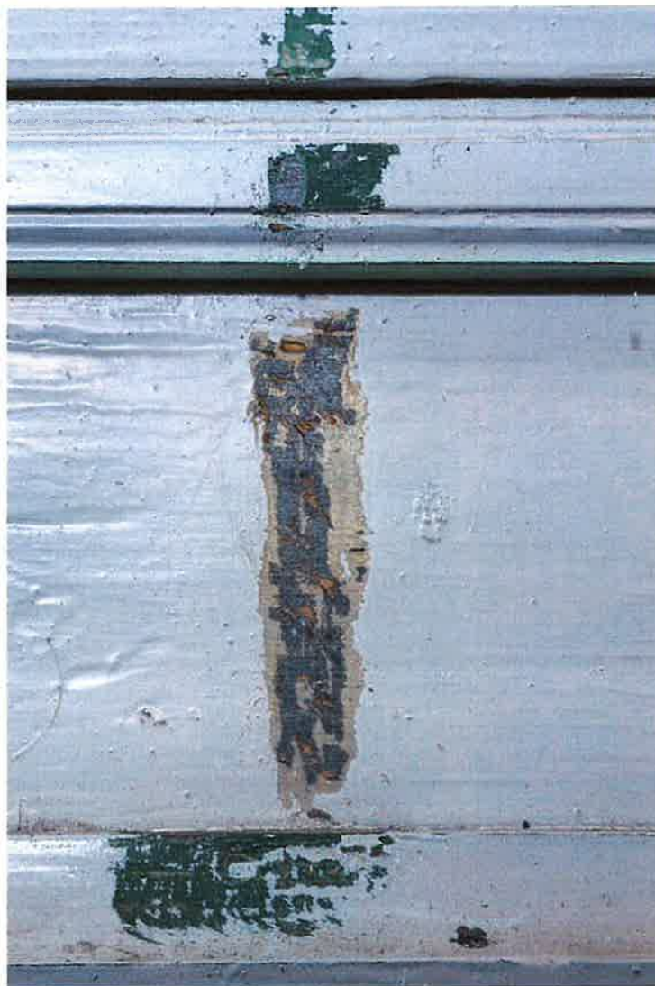
Fot. 17. Fragment odkrywki na 5 poniżej prospektu organowego. Empora opracowana była pierwotnie analogicznie do ławek – najstarsza chronologicznie jest warstwa w kolorze szarym, na niej kolejna – zielona i widoczna obecnie biała.
