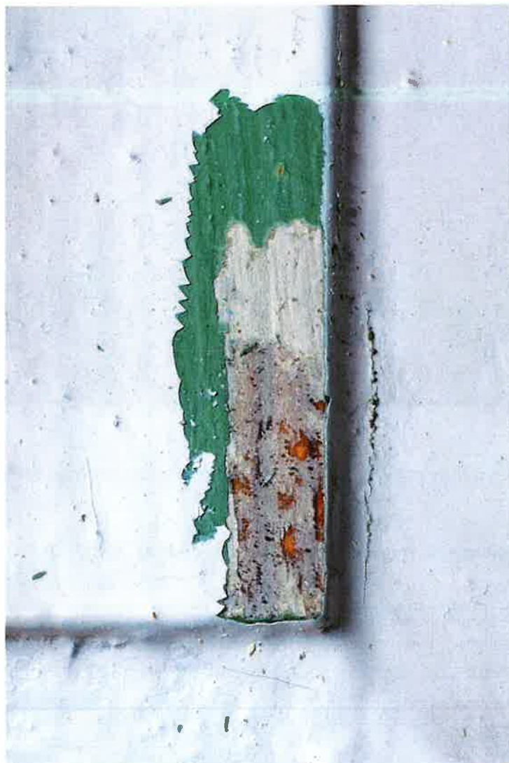
Fot. 25. Odkrywka na płycinie ściany ambony.
