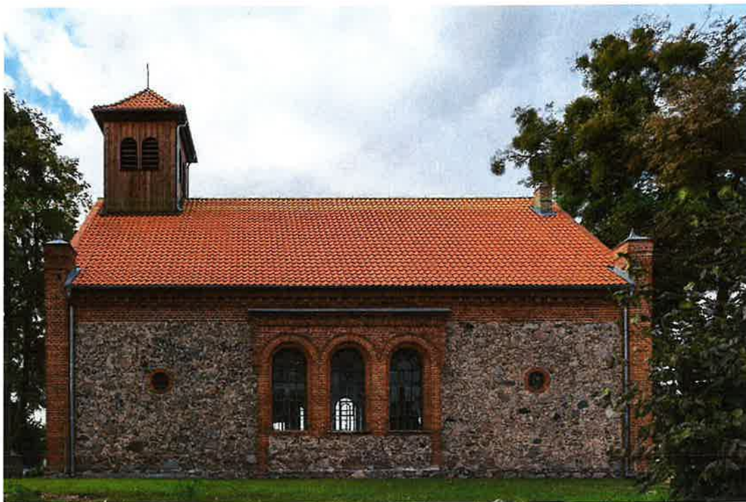
Fot. 3. Kościół w Rybnie, elewacja południowa.
