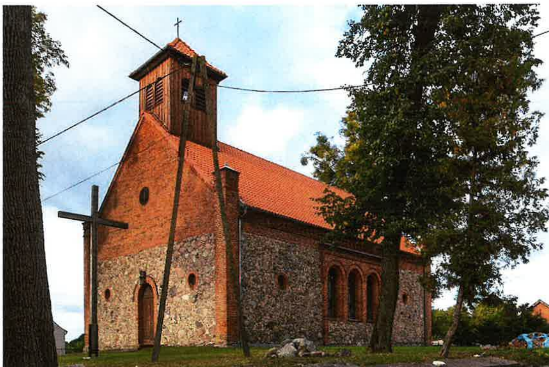
Fot. 2. Kościół w Rybnie, widok od południowego zachodu.
