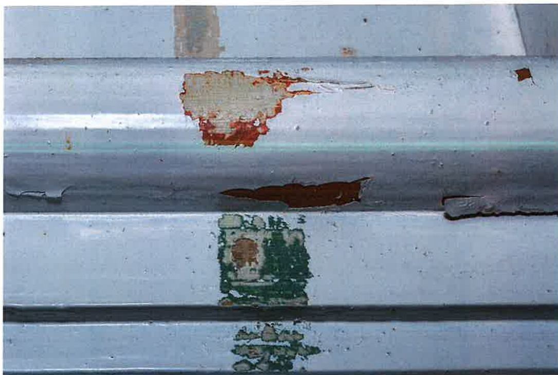
Fot. 18. Górna część odkrywki nr 5 – prospekt organowy pierwotnie opracowano inaczej niż ławki i empore. Najstarsza chronologicznie warstwa malarska ma kolor jasnoszary (niebieskawy). Kolejna aranżacja to opracowanie wielobarwne w kolorach zielonym (analogicznym do drugiej warstwy na ławkach) i bordowym – podobnym do odcienia pasów, które wymalowano na ścianach w drugiej fazie wystroju.
