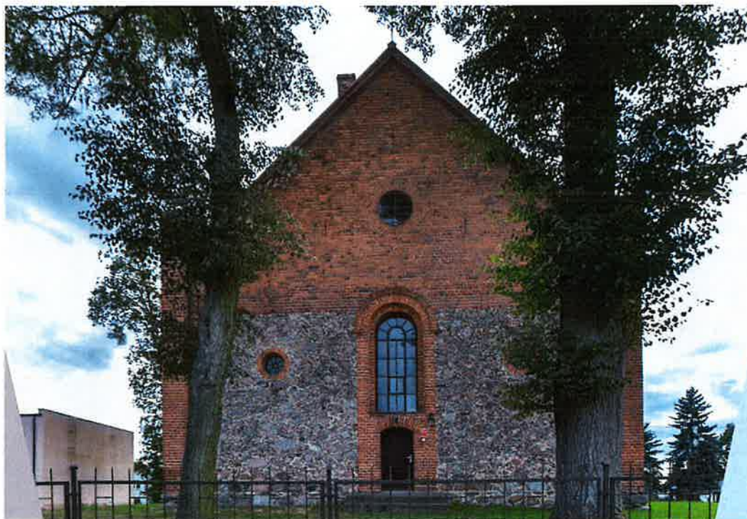
Fot. 6. Kościół w Rybnie, elewacja wschodnia.
