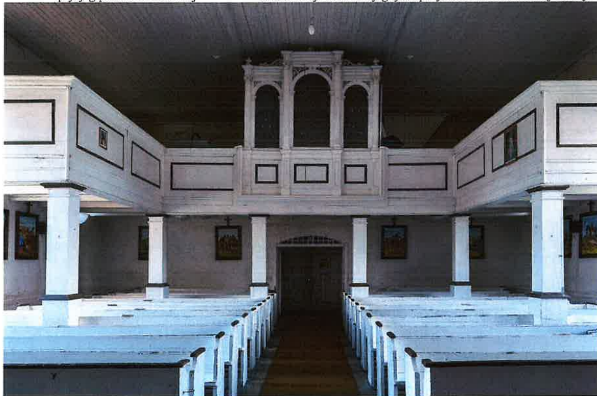
Fot. 8. Wnętrze kościoła – widok w kierunku wejścia oraz empyry organowej. Prospekt organowy umieszczono w centrum. Szerokie, profilowane listwy, którymi otoczono boczne krawędzie przysłoniły fragmenty ozdobnych listew na płycinach, co może dowodzić, iż prospekt jest późniejszy, wkomponowany w istniejącą już balustradę.
