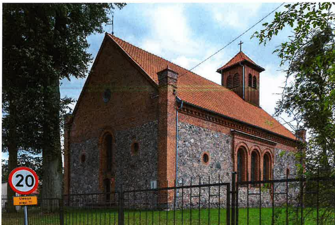
Fot. 5. Kościół w Rybnie, widok od północnego wschodu.
