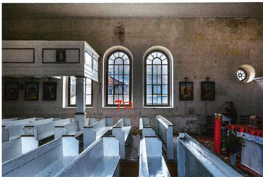
Fot. 32. Wnętrze kościoła. Widok w kierunku ściany północnej. Na zdjęciu zaznaczono lokalizację odkrywk nr 7 na wewnętrznej powierzchni skrzydła okna.
