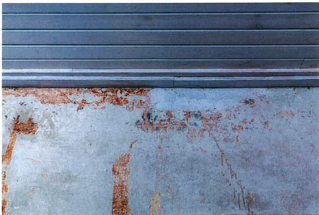
Fot. 48. Fryz widoczny na ścianie w formie białego negatywu najprawdopodobniej był wymalowany farbą w kolorze niebieskim.
